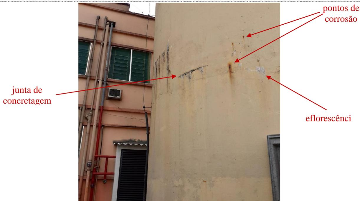
**IMAGEM Nº 21: JUNTA DE CONCRETAGEM, PONTOS DE CORROSÃO, EFLORENCENCIA**
