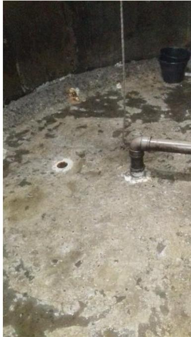
**IMAGEM N° 29: RESERVATÓRIO VAZIO, IMPERMEABILIZAÇÃO SOLTANDO**
