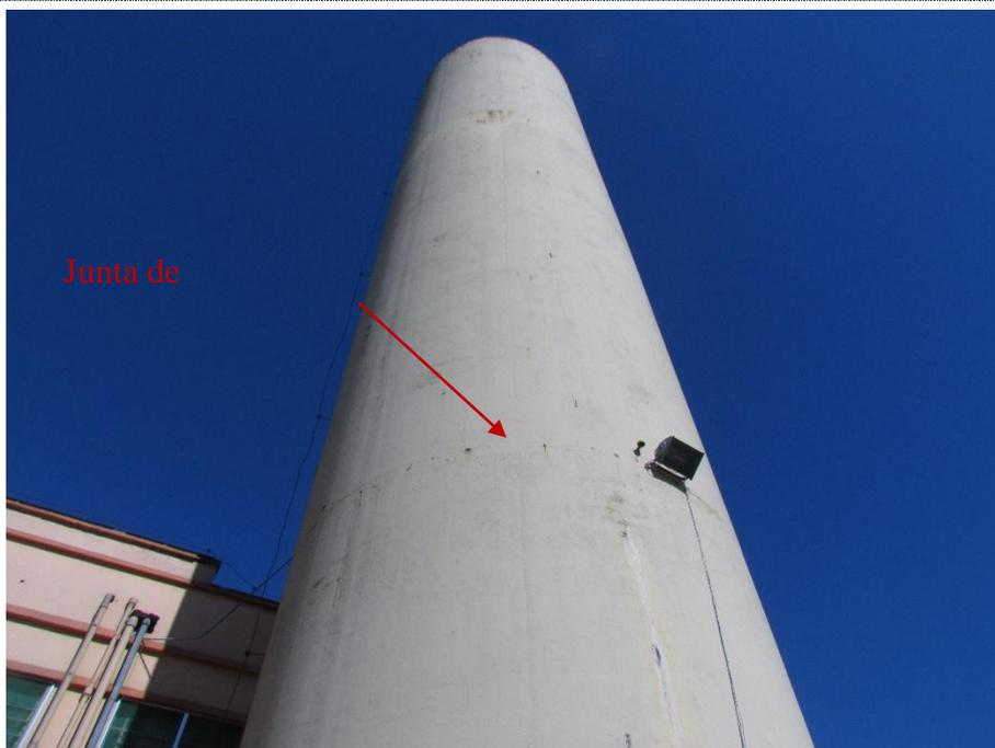
**IMAGEM Nº 07: JUNTA CONCRETAGEM NA FACE SUPERIOR DA TAMPA DO
