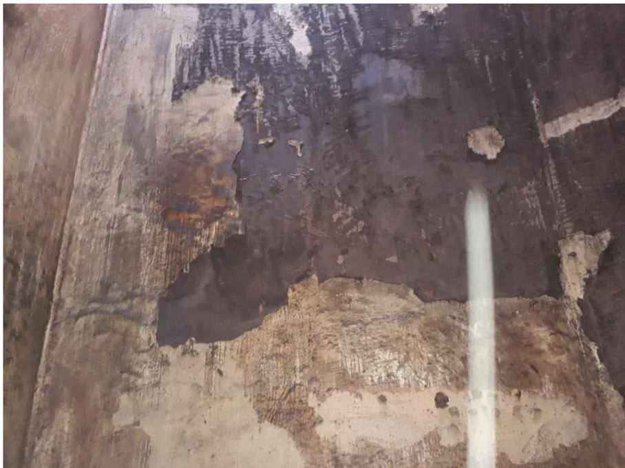
**IMAGEM N° 30: PAREDES LATERAIS COM IMPERMEABILIZAÇÃO SOLTANDO**
