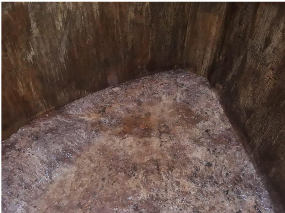
**IMAGEM N° 34: FUNDO DO RESERVATÓRIO COM PAREDES SEM RODAPÉ
