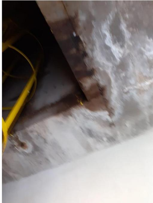
**IMAGEM N° 25: VAZAMENTO NA LAJE DE FUNDO**
