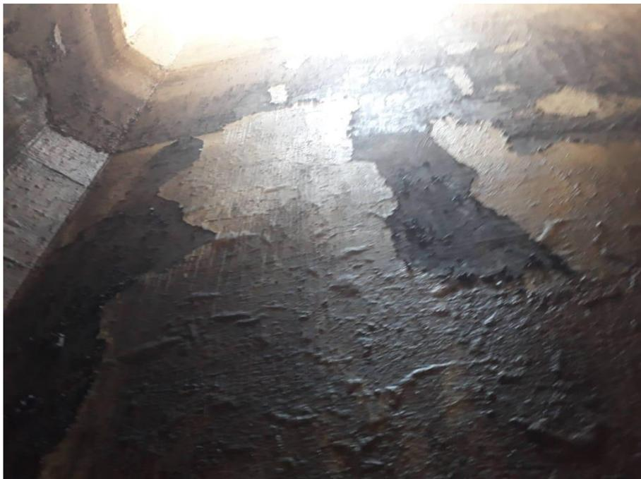
**IMAGEM N° 31: PAREDE LATERAL COM IMPERMEABILIZAÇÃO SOLTANDO**
