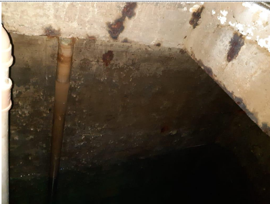
IMAGEM N° 23: IMPERMEABILIZAÇÃO DEFICIENTE, DEVE SER REFEITA
