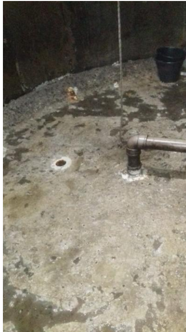
IMAGEM N° 29: RESERVATÓRIO VAZIO, IMPERMEABILIZAÇÃO SOLTANDO
