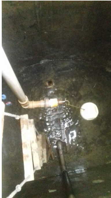
IMAGEM N° 28: RESERVATÓRIO SENDO ESVAZIADO
