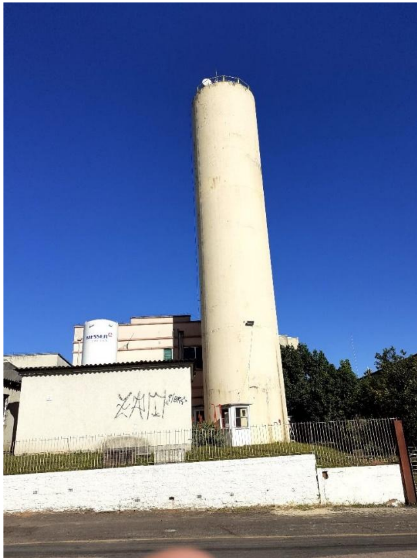
IMAGEM 01: RESERVATÓRIO ELEVADO – VISTA GERAL LESTE
