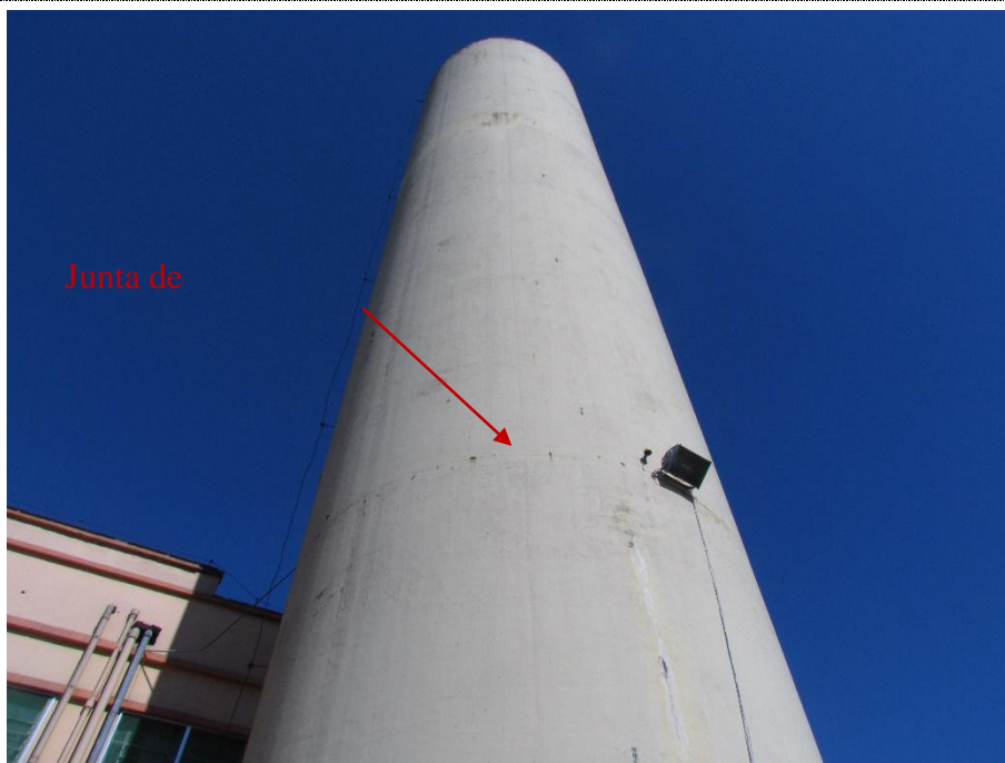
IMAGEM Nº 07: JUNTA CONCRETAGEM NA FACE SUPERIOR DA TAMPA DO RESERVATÓRIO INFERIOR
