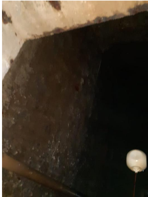
IMAGEM N° 24: IMPERMEABILIZAÇÃO DEFICIENTE, DEVE SER REFEITA
