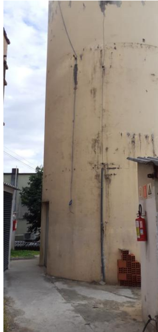
IMAGEM N° 22: RESERVATÓRIO JUNTO AO PISO
