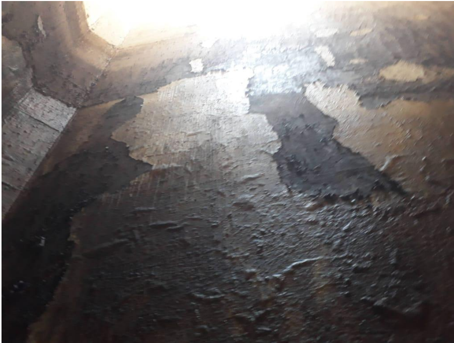
IMAGEM N° 31: PAREDE LATERAL COM IMPERMEABILIZAÇÃO SOLTANDO
