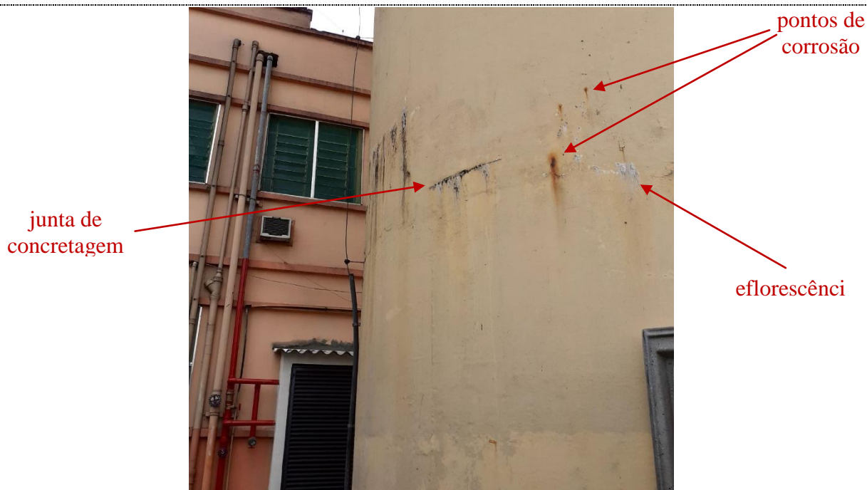
IMAGEM Nº 21: JUNTA DE CONCRETAGEM, PONTOS DE CORROSÃO, EFLORENCENCIA
