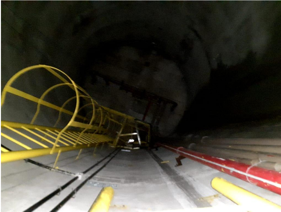
IMAGEM N° 37: ESCADA DE ACESSO AO RESERVATÓRIO SUPERIOR
