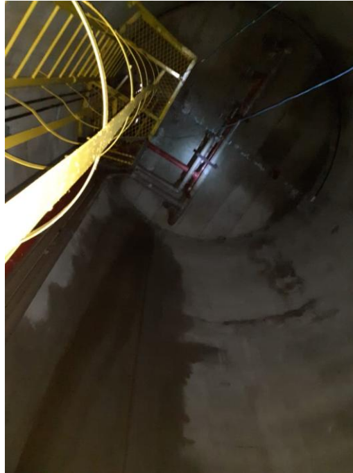
IMAGEM N° 38: ÁGUA ESCORRENDO POR CONTA DA TUBULAÇÃO DE PVC DANIFICADA
