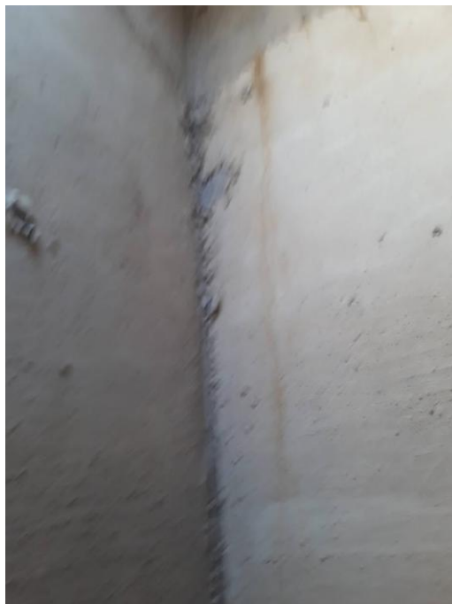
IMAGEM N° 32: PAREDE SUPERIOR SEM IMPERMEABILIZAÇÃO
