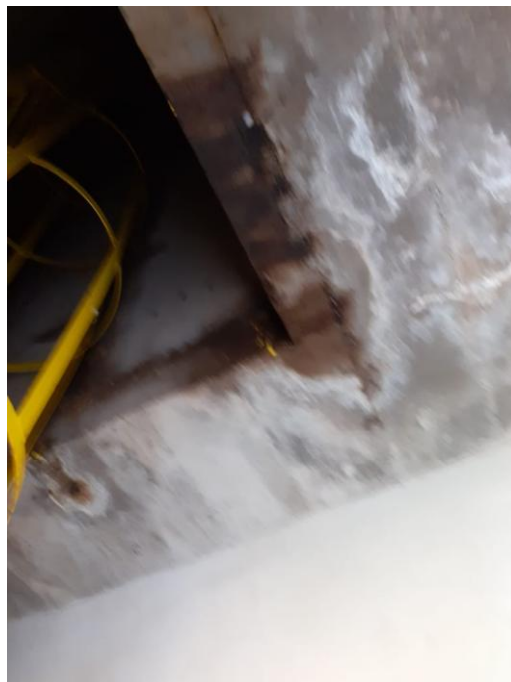
IMAGEM N° 25: VAZAMENTO NA LAJE DE FUNDO
