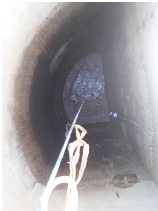
IMAGEM N° 26: VISTA GERAL DO RESERVATÓRIO
