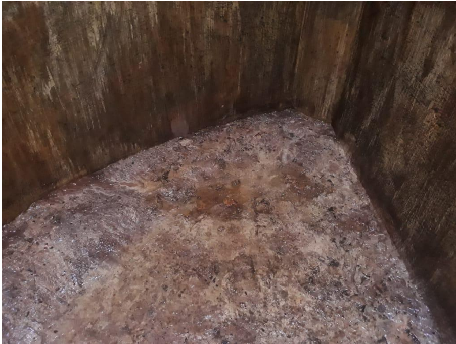
IMAGEM N° 34: FUNDO DO RESERVATÓRIO COM PAREDES SEM RODAPÉ E IMPERMEABILIZAÇÃO SOLTANDO
