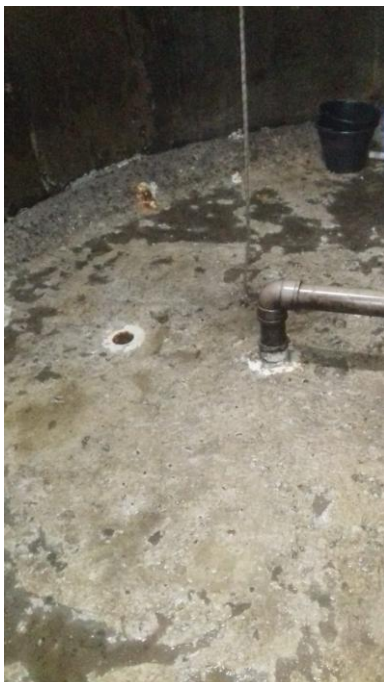
IMAGEM N° 29: RESERVATÓRIO VAZIO, IMPERMEABILIZAÇÃO SOLTANDO
