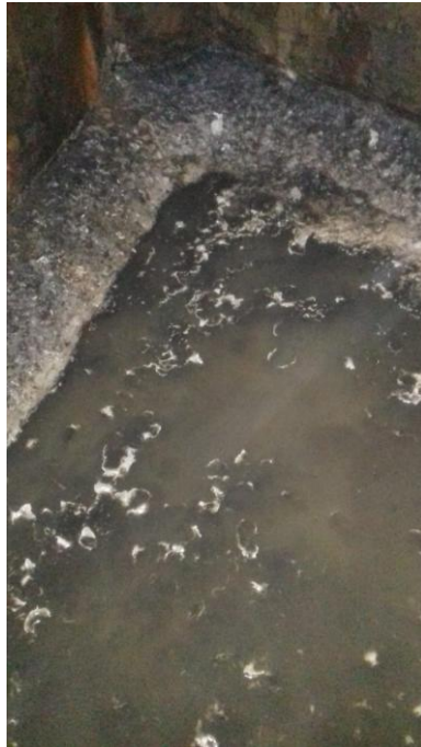
IMAGEM N° 33: IMPERMEABILIZAÇÃO SOLTANDO
