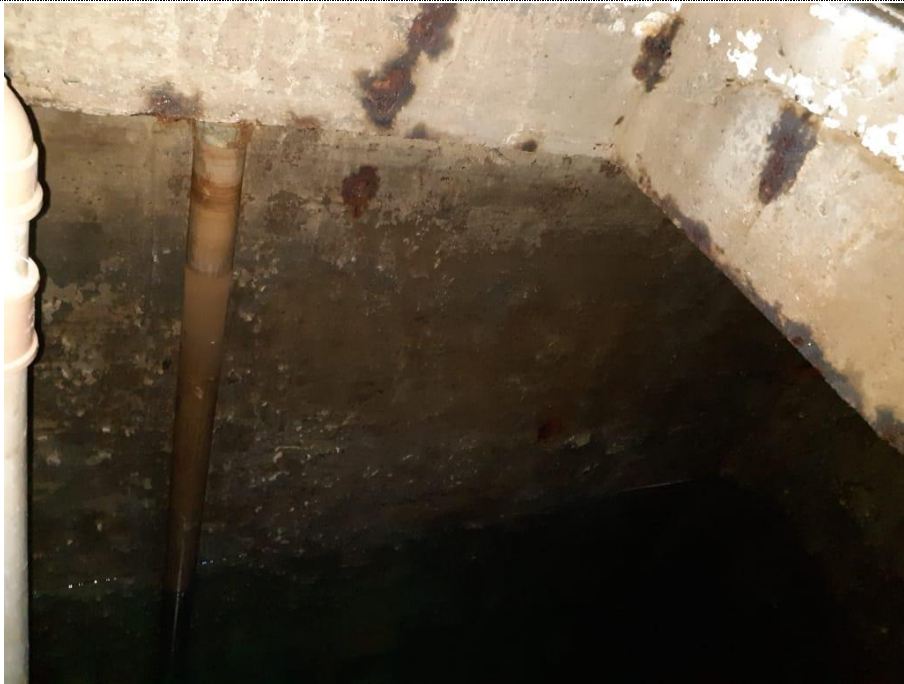
IMAGEM N° 23: IMPERMEABILIZAÇÃO DEFICIENTE, DEVE SER REFEITA
