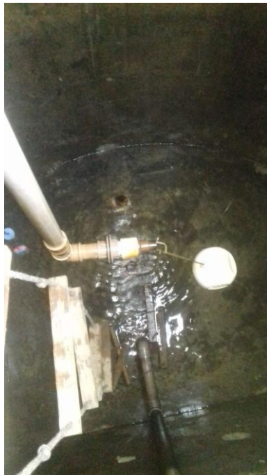
IMAGEM N° 28: RESERVATÓRIO SENDO ESVAZIADO
