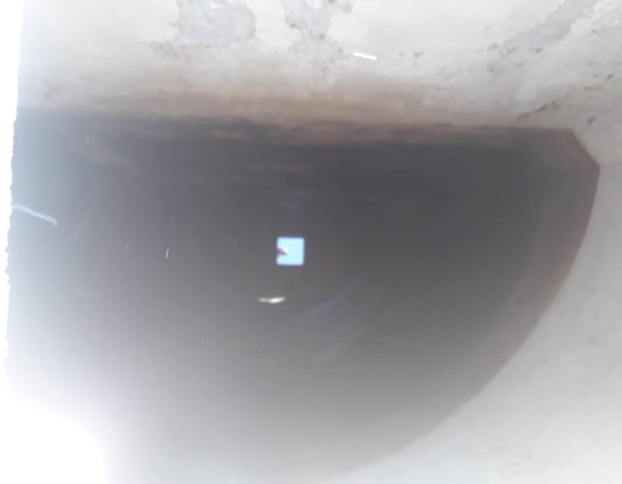
IMAGEM N° 36: VÃO DA ESCADA
