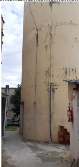
IMAGEM N° 22: RESERVATÓRIO JUNTO AO PISO
