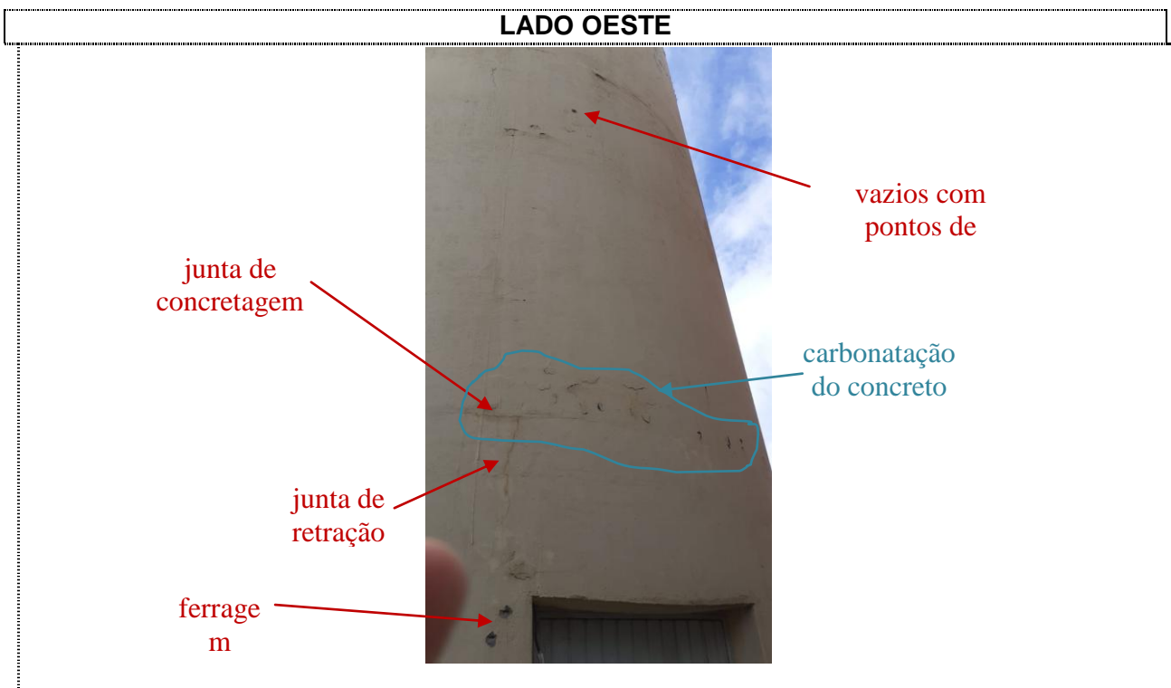
IMAGEM Nº 14: JUNTAS DE CONCRETAGEM ACIMA E ABAIXO DA TAMPA DO 1º RESERVATÓRIO E
