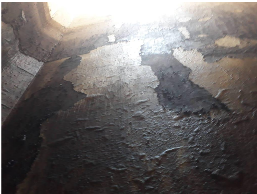
IMAGEM N° 31: PAREDE LATERAL COM IMPERMEABILIZAÇÃO SOLTANDO
