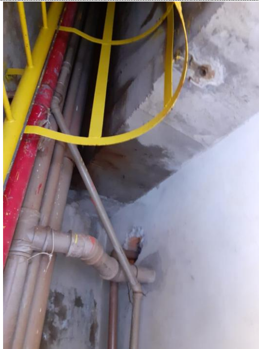
IMAGEM N° 39: ÁGUA ESCORRENDO POR CONTA DA TUBULAÇÃO DE PVC DANIFICADA
