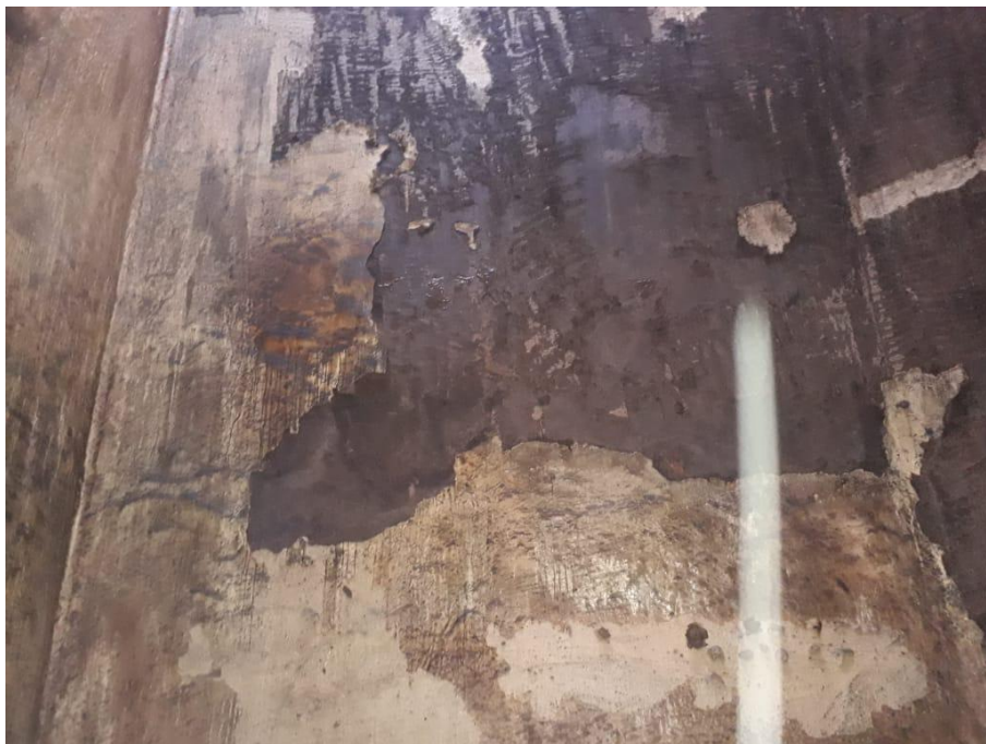
IMAGEM N° 30: PAREDES LATERAIS COM IMPERMEABILIZAÇÃO SOLTANDO
