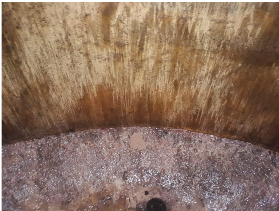
IMAGEM N° 35: PAREDE LATERAL E FUNDO DO RESERVATÓRIO SEM RODAPÉ
