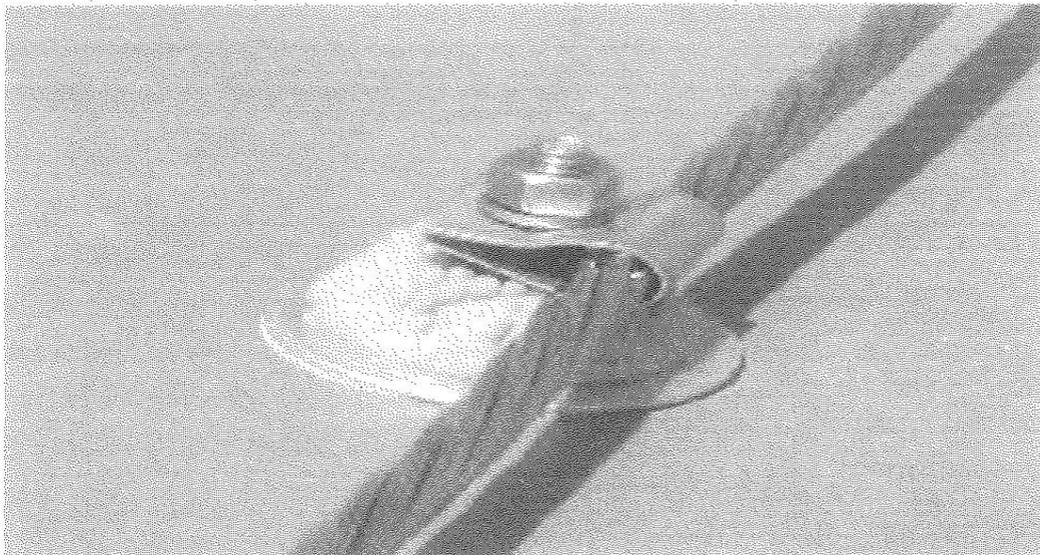
Figura 2. Fixação do cabo de captação sobre telhas
