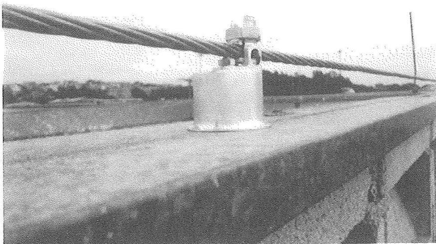
Figura 1. Fixação do cabo de captação sobre rufos
